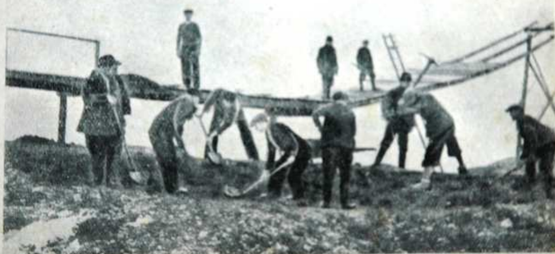
Powyższe zdjęcie przedstawia fragment skoczni w czasie budowy, wraz z grupą robotników i członków klubu (na pierwszym planie), zajętych przy budowie skoczni
