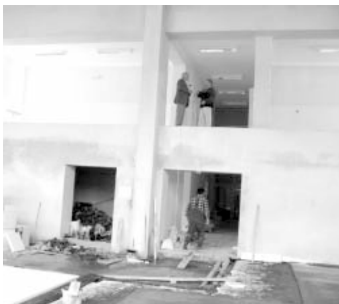
Budowa sali przy SP nr 2
