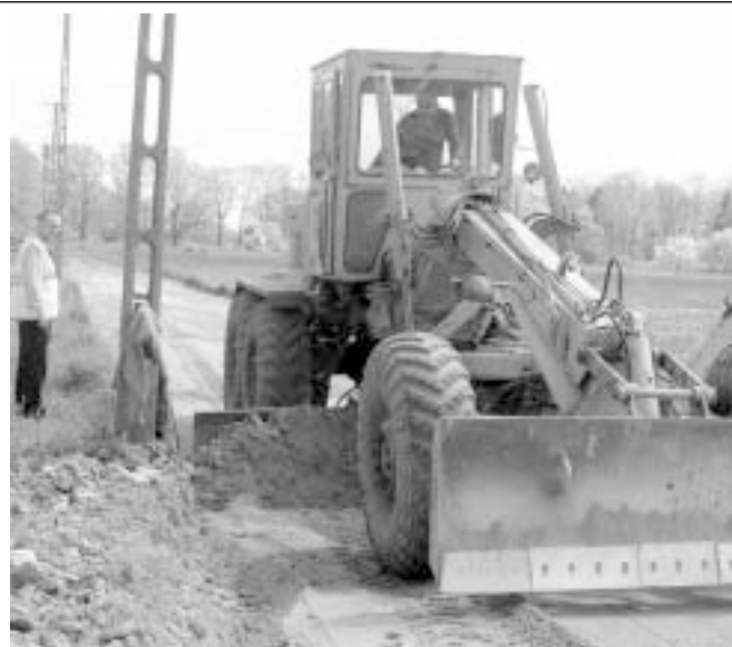
Budowa drogi na ul. Cichej.
