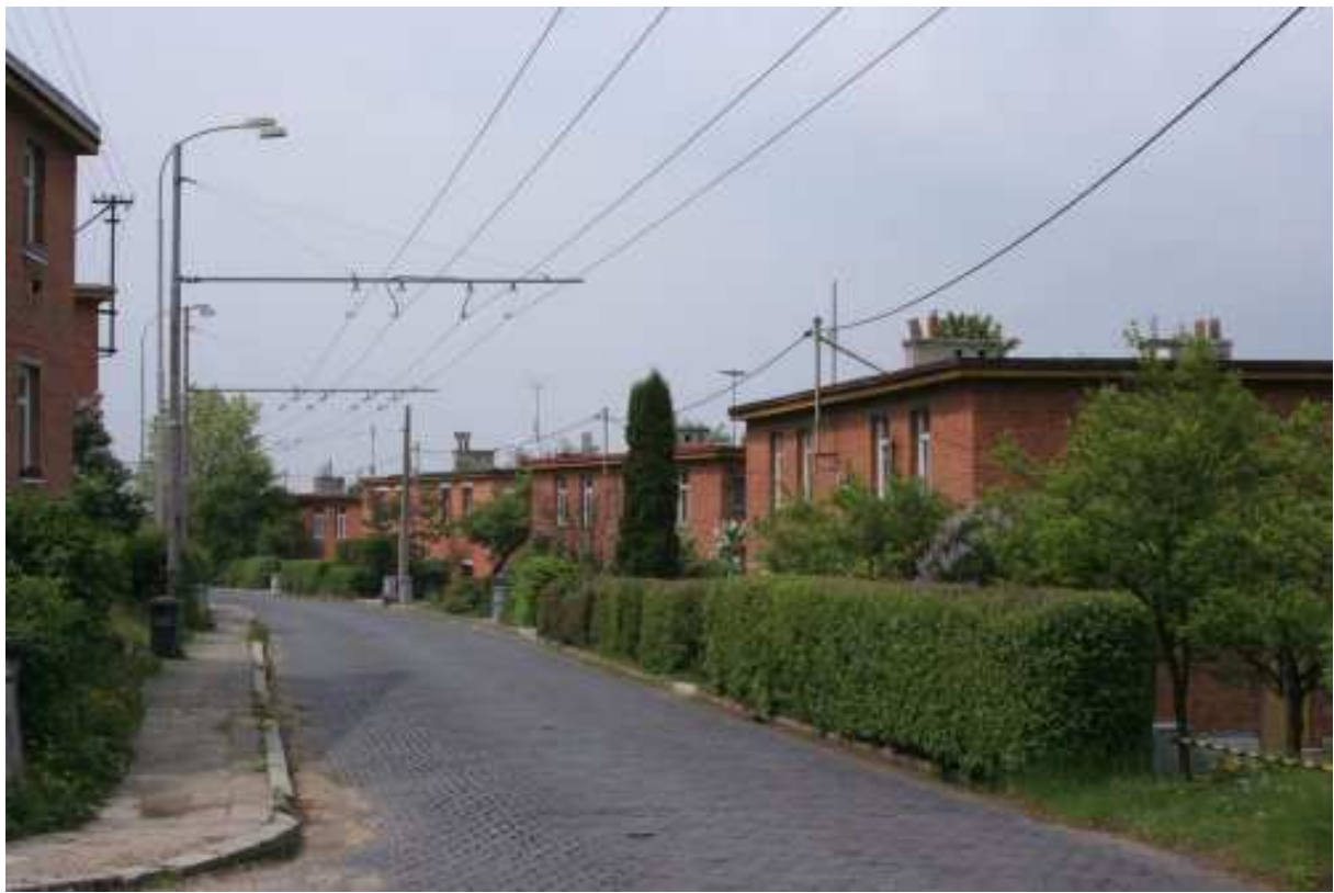
Zlín, domy dla robotników, fot. Seweryn Puchała
