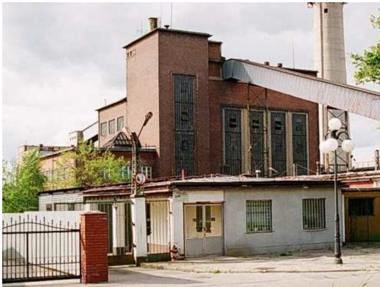
Chelmek, kotłownia, fot. A. Syska
